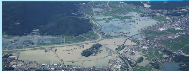
武雄市北方町付近 (令3.8) 提供：佐賀県河川砂防課
