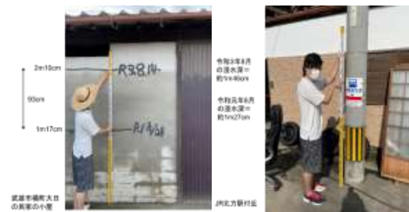
写真1 武雄市における浸水の痕跡線調査(8月19日)
