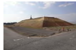
有明海沿岸道路試験盛土 (動態観測)実施中
