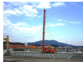
武雄バイパス工事の様子
