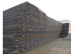
補強土擁壁工法施工状況 (有明海沿岸道路)
