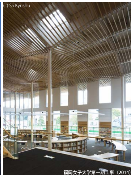
福岡女子大学第一期工事 (2014)
