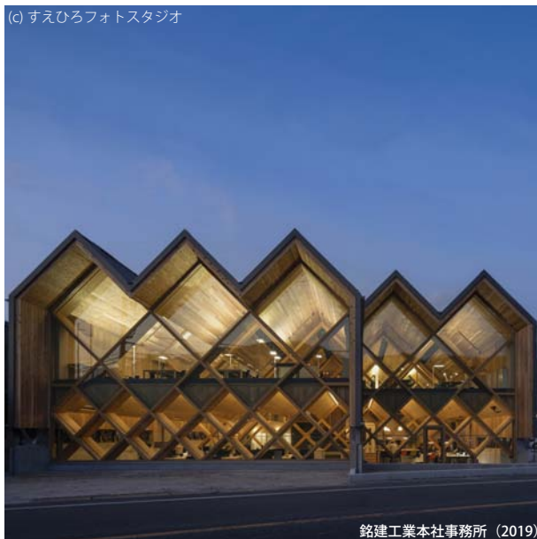
銘建工業本社事務所 (2019)
