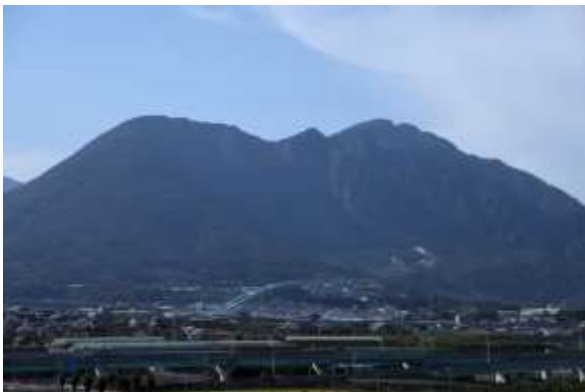
眉山の崩壊斜面
